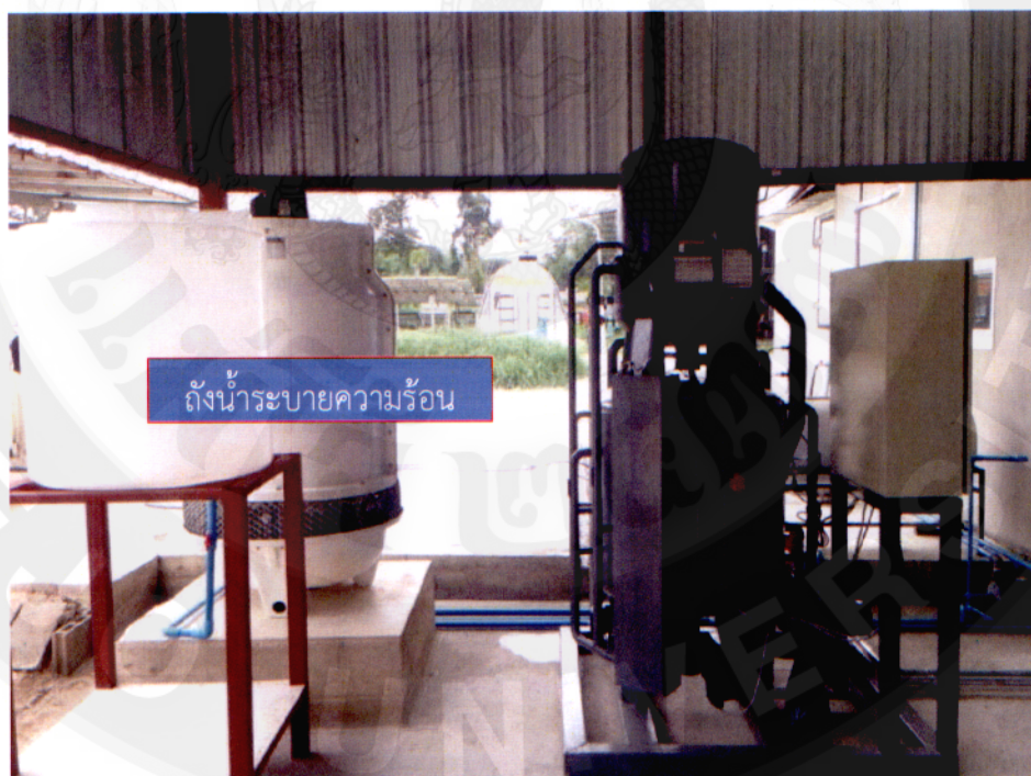
ภาพที่ 22 ภาพโดยรวมของระบบทำความเย็นแบบดูดกลืนแสดง (ด้านข้างซ้าย)
