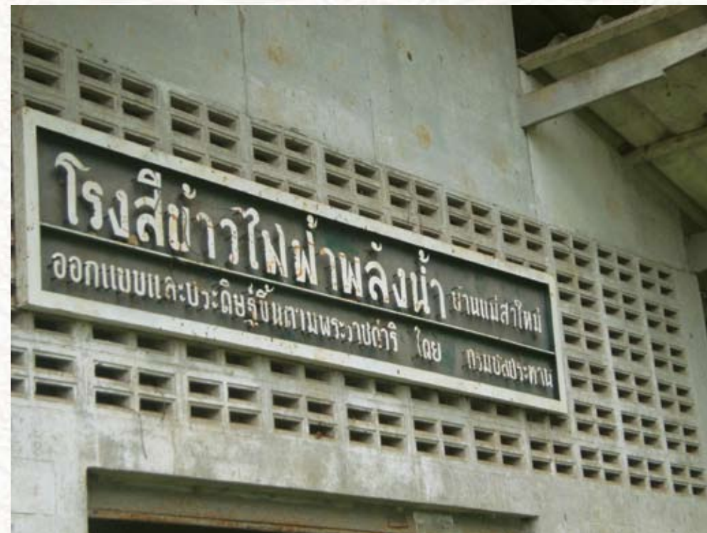
▲ ภาพที่ ๑๓๐ : อาคารโรงสีข้าวไฟฟ้าพลังน้ำบ้านแม่สาใหม่
