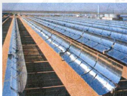
รูปที่ 8 แสดงภาพถ่ายจริงของตัวรับแสงแบบ Parabolic troughs (ซ้าย) และ แผนภาพแสดงหลักการ ทำงานของตัวรับแสงนี้ (ขวา)
