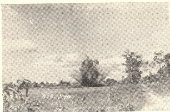
การใช้ดินระเบิดล้มต้นไม้ Felling old steme with dynamite
